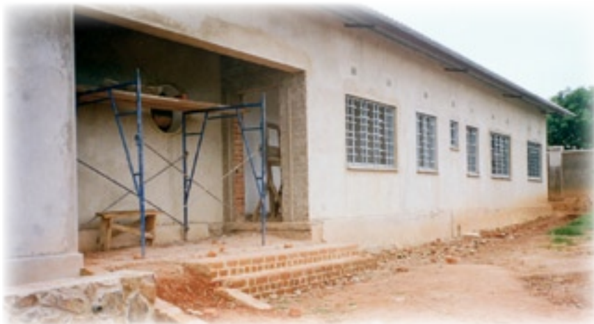
▼ Casa de acogida Luis Amigó. En construcción
