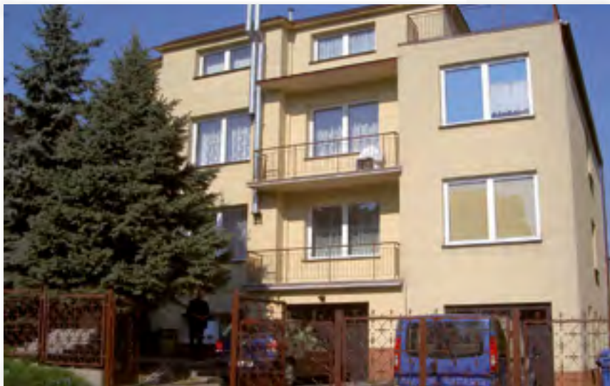
▲ Fachada de la institución
