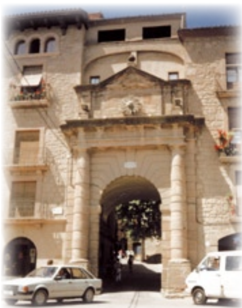
Puerta de ingreso a la ciudad de Solsona. ▲
